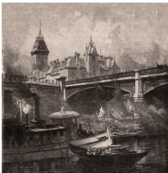
Figure 2.5 Sous le pont Dufferin
